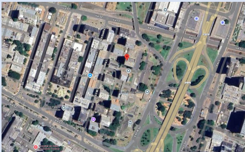
Figura 2 - Edifício Alvorada (vista aérea)
